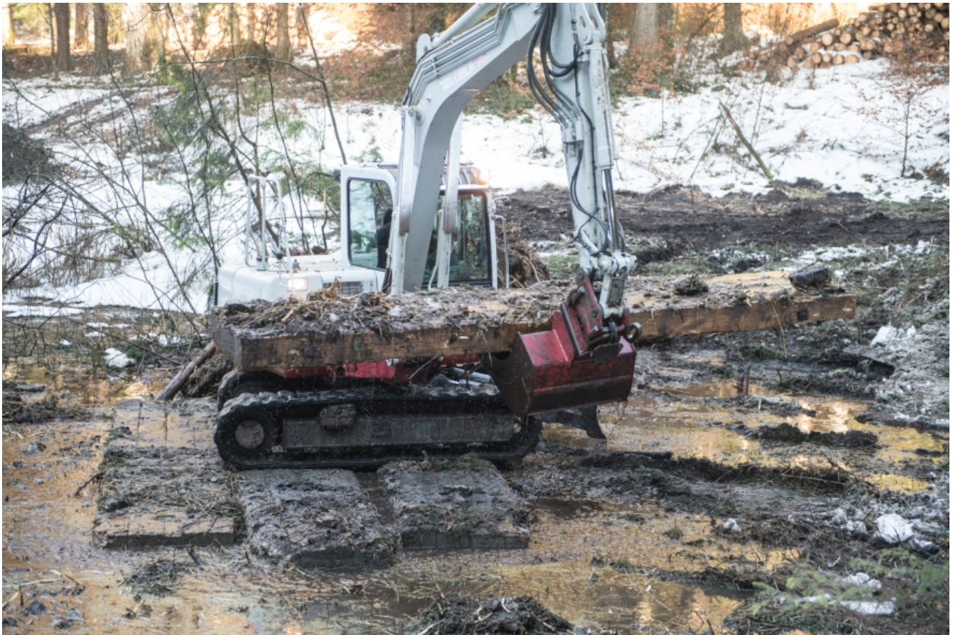
Baggerarbeiten (Foto: Reinold Amann)
