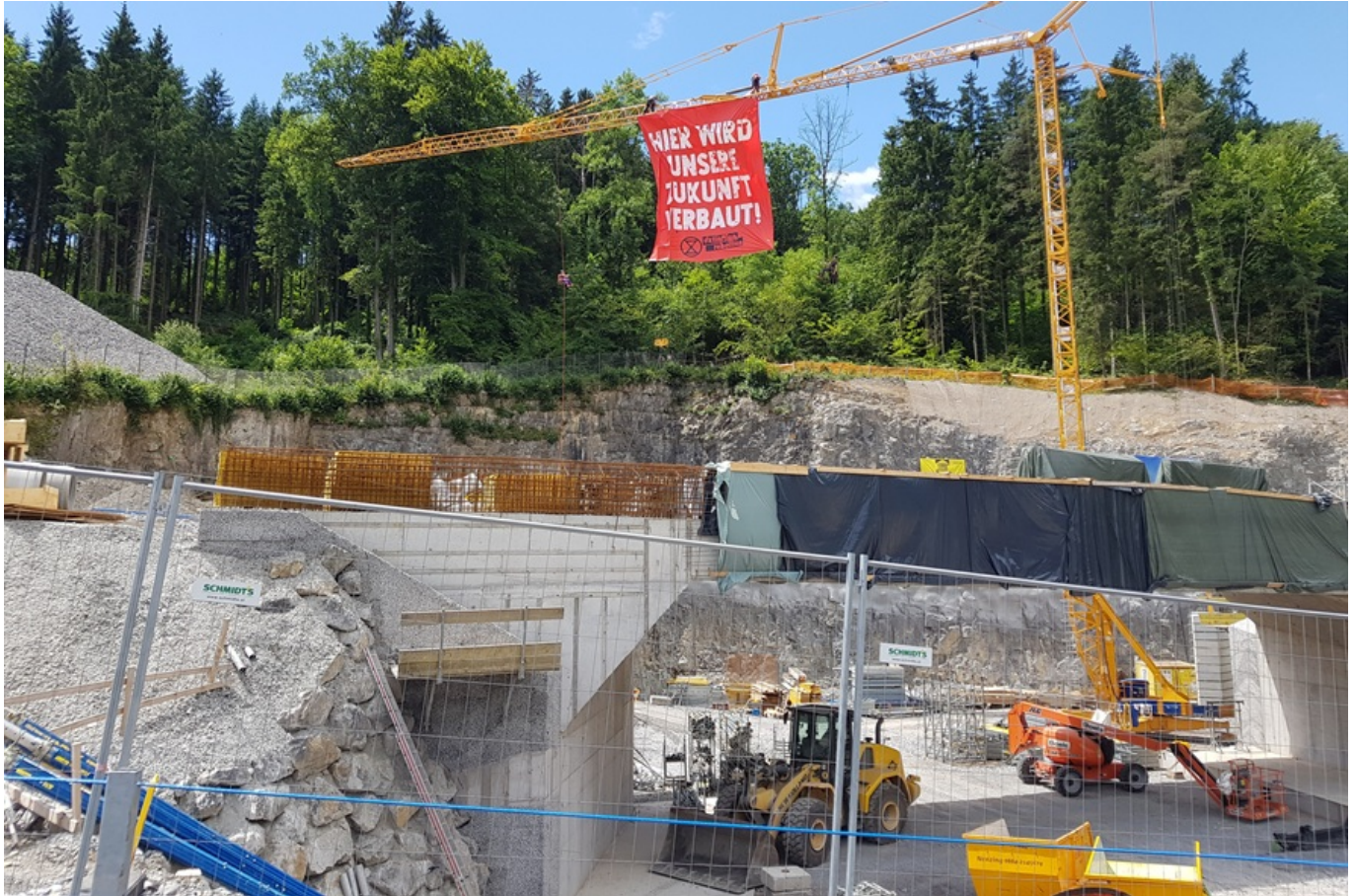
Baustelle Tunnelspinne © Bianca Burtscher
