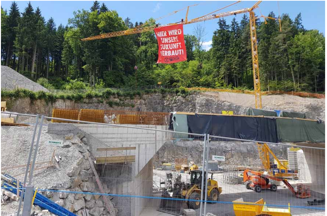
Baustelle Tunnelspinne © Bianca Burtscher
