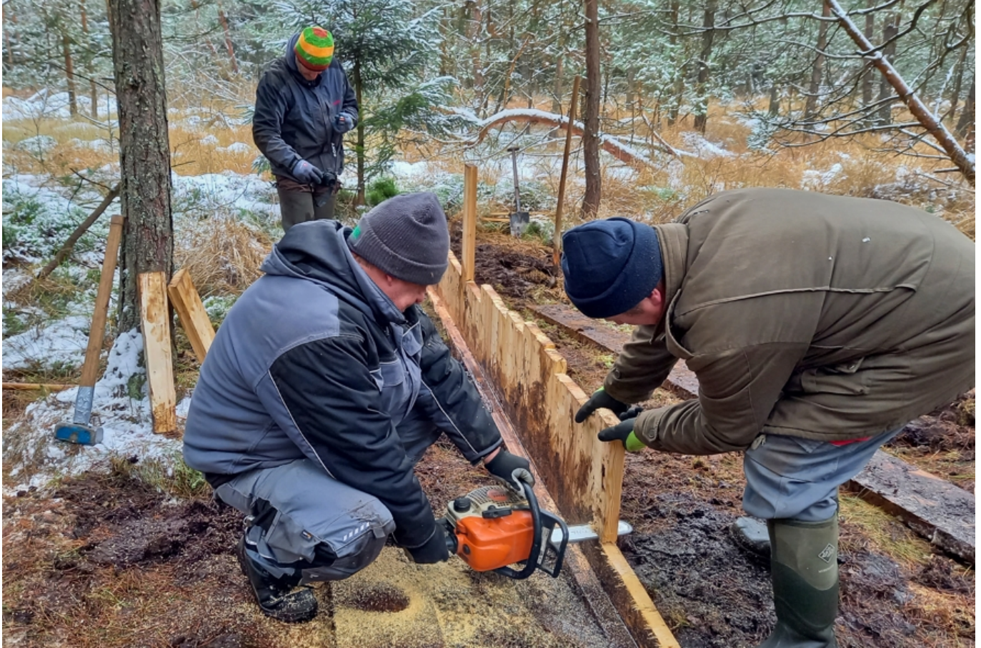
Wiederherstellungsmaßnahmen in einem Waldviertler Moor
