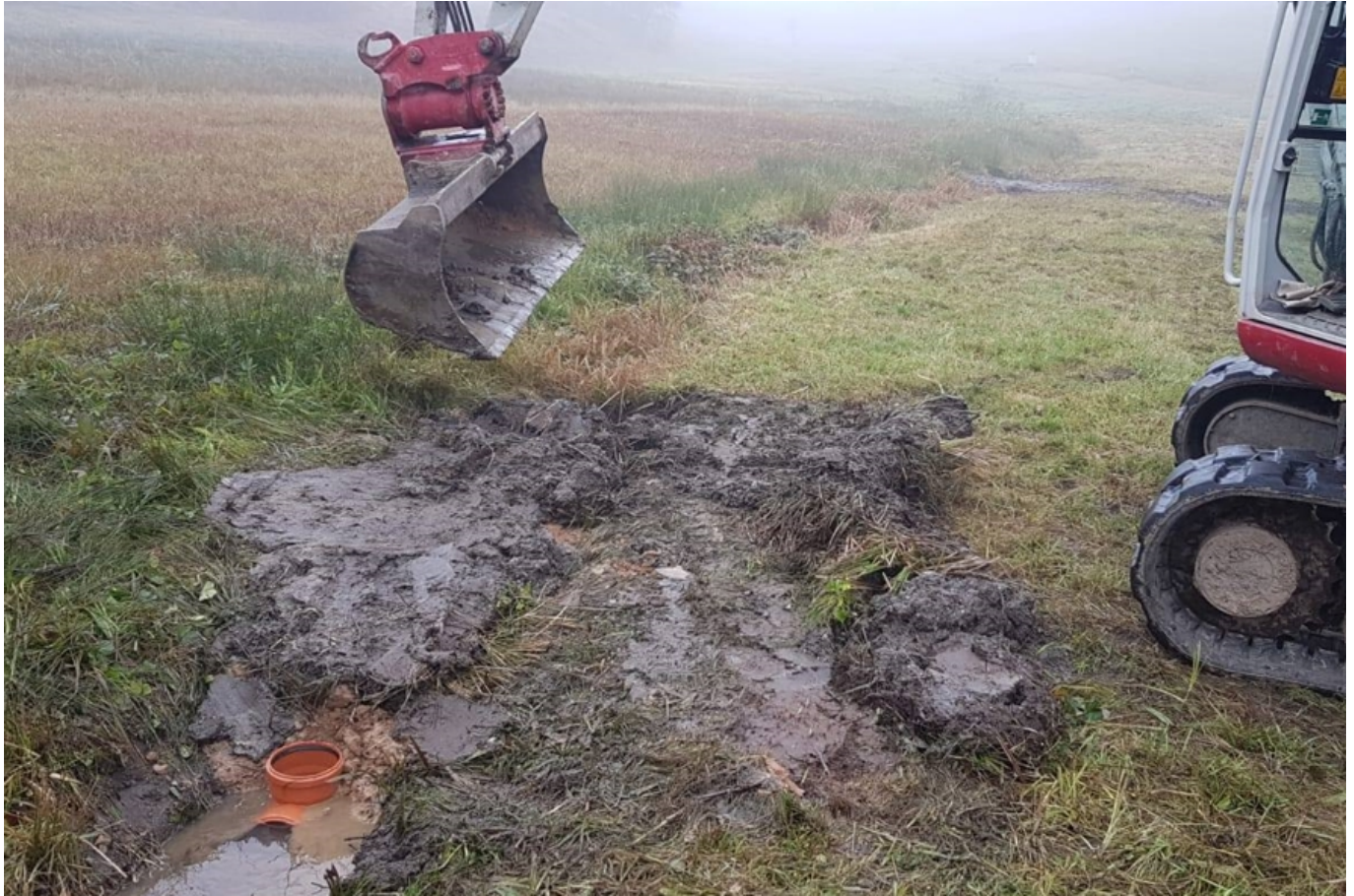
Einbau des Lehmriegels © Axel Schmidt
