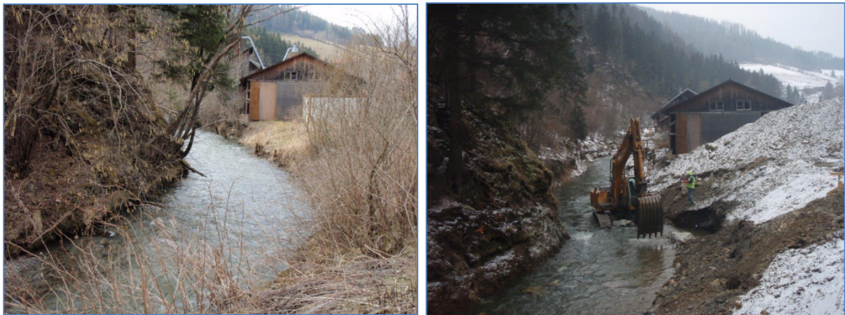
Abb. 11: Laming Mittellauf, links im März 2010 und rechts im Februar 2011 bei Grabungsarbeiten zur Unterwassereintiefung im Zuge der Revitalisierung und Leistungssteigerung eines damals stillliegenden Kraftwerkes; man beachte die Mengen des Aushubs im rechten Bild.
