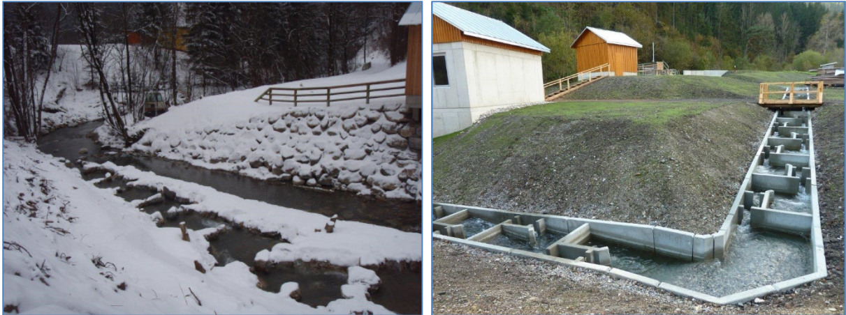
Abb. 15: Zwei Fischleitern im Bereich neu errichteter Ausleitungskraftwerke im Mittellauf der Laming. Diese Fischaufstiegshilfen sind nicht otterdicht eingezäunt. Auf Grund der geringen Wassermengen und Gewässerbreite sind die Fische dort für den Otter deutlich leichter erbeutbar als im Hauptfluss mit natürlicher Wasserführung.
