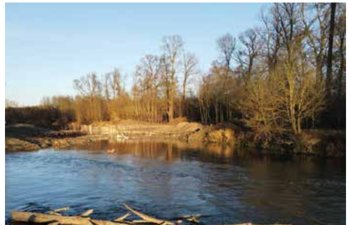
Neben der Strukturierung mit Wasserbausteinen erfolgt eine Aufwertung des Lebensraums durch ingenieurbioologische Maßnahmen. Hierzu werden Bäume im Uferbereich zur Strukturierung und als Uferschutz eingebracht. (c) viadonau
