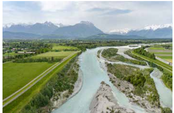
Das Projekt Rhesi erhöht die Abflusskapazität des Rheins und verbessert so den Hochwasserschutz. Hier eine Visualisierung der Aufweitungen an der Frutzmündung. Visualisierung (c) IRR
