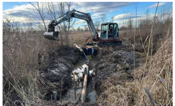
Dambalken fördern den Wasserrückhalt in den Gräben und verlängern den Einstau potenzieller Laichplätze. Bild: T. Zuna-Kratky
