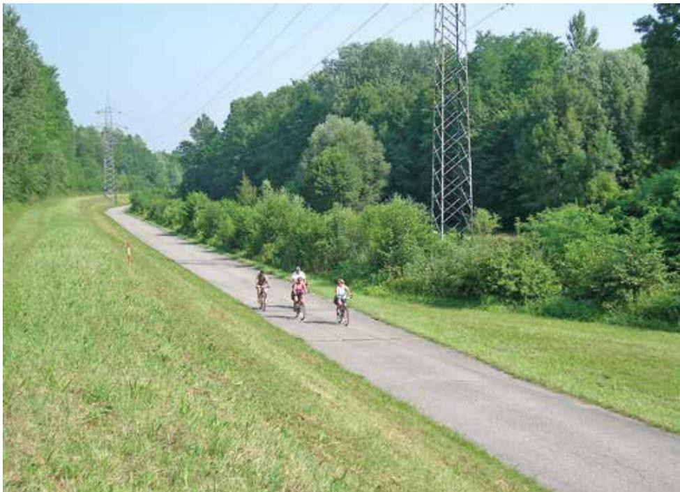
Rückstaudamm des Kraftwerkes Obervogau mit asphaltierter Begleitstraße; dahinter großflächig abgedämmter Auwald.
