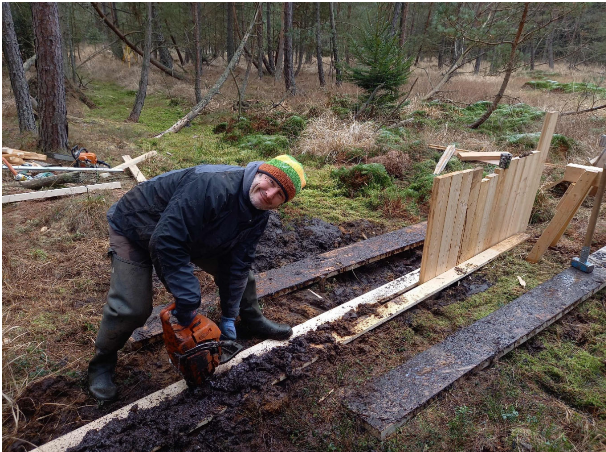
Abbildung 46 Einbau von Holzsperrn zur hydrologischen Sanierung des Bummermoos. Winter 2020. Foto J. Brocks
