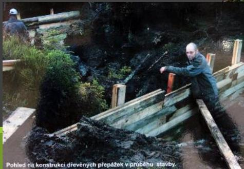
Pohled na konstrukci dřevěných přepážek v průběhu stavby.
