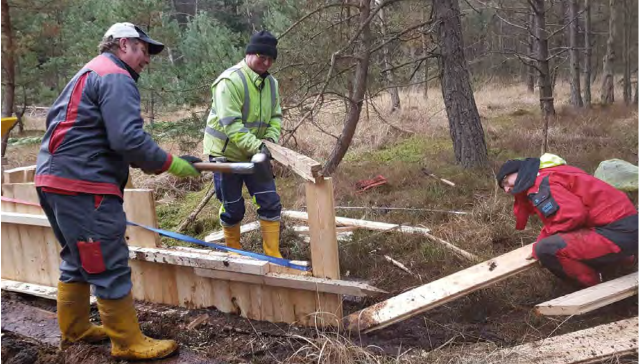
Einbau einer Holz-Spundwand im Dezember 2020 im Bummermoos
