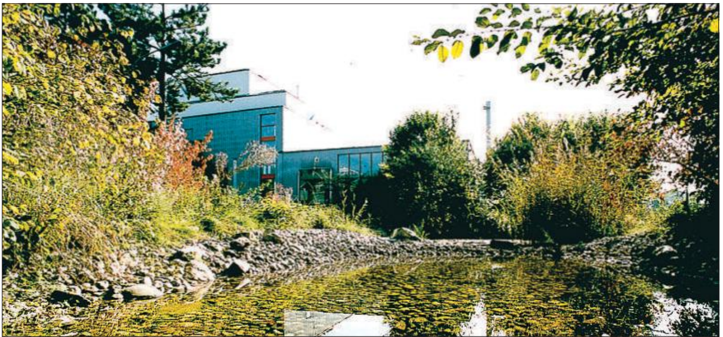
Regenwasser über Lehm und Kies versickern zu lassen, anstatt es abzuleiten, spart jedem Unternehmen Geld. Bei GIKO dient das Biotop zudem als Pausenplatz für Mitarbeiterinnen und Mitarbeiter.
