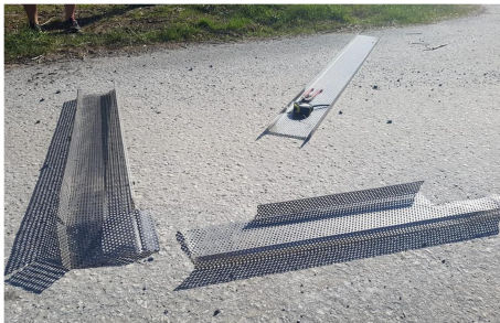
Zum Einbau in Viehsperren vorbereitete Lochbleche © Willi Schwarzenbacher
