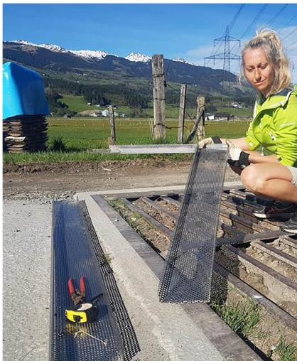
Montage der Lochbleche bei einer Viehsperre in Bramberg © Willi Schwarzenbacher
