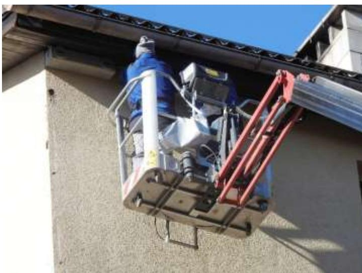
Montage von Ersatz-Brutplätzen vor Verschluss der Spechtlöcher und Anbringung eines Kantenschutzes
