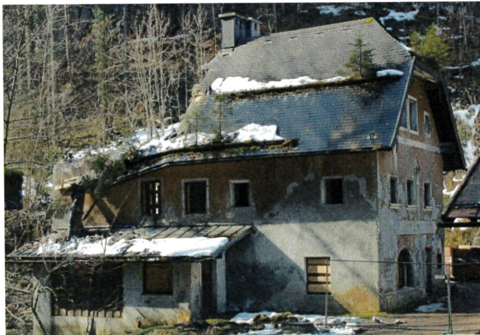
Das Wolf-Dietrich-Berghaus / Hallein (errichtet 1597/98) wurde 2015 abgerissen
