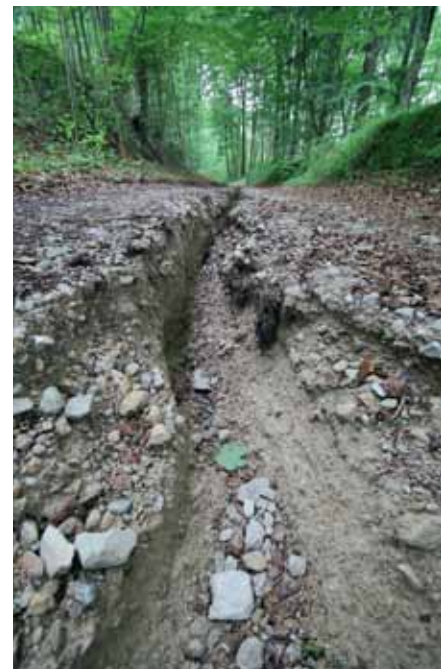
Starkregen mit Schürfkraft: Starkregen gräbt bei Forstwegen oft neue „Bachbette“ aus und verlagert Material talwärts
