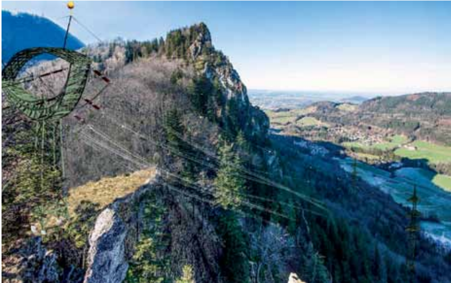
380 kV-Leitung im Bereich des Nocksteins. Visualisierung Robert Marschallinger
