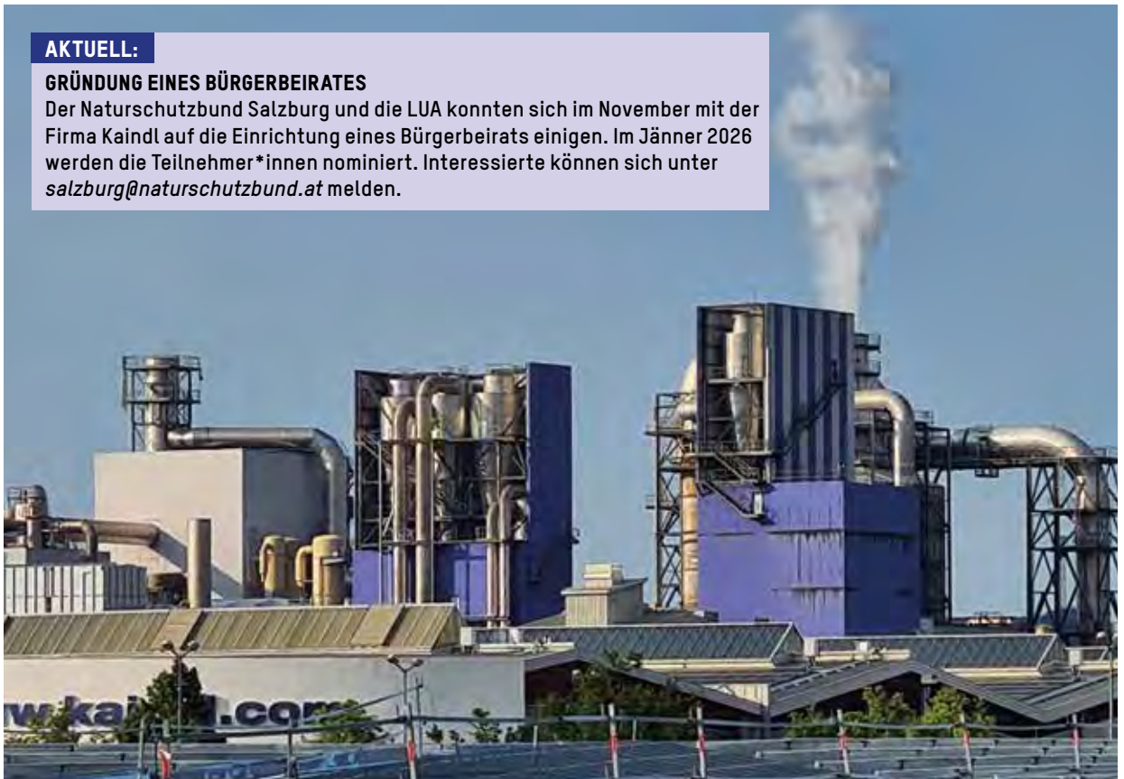
Betriebsanlage der Firma Kaindl in Wals © HANNES AUGUSTIN
