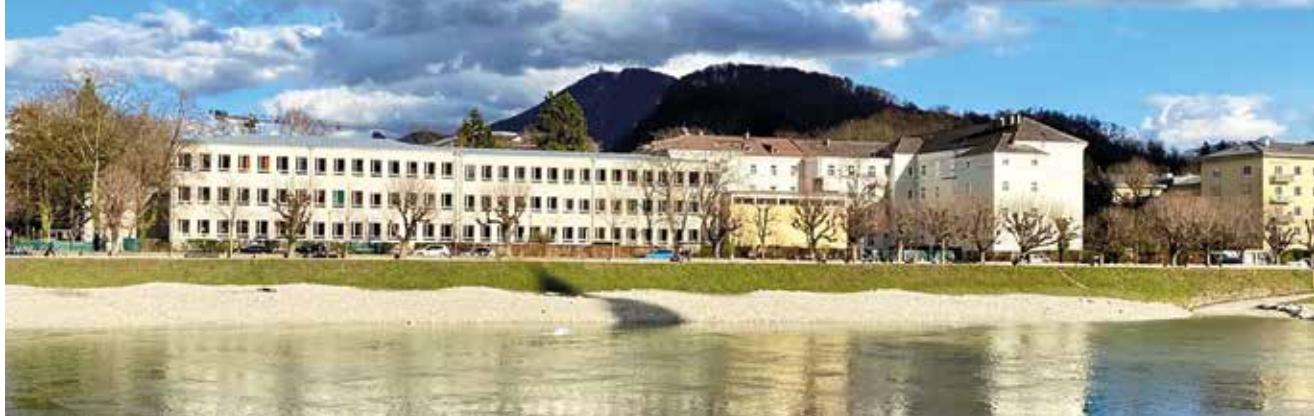
Bau-Ensemble Schule Schwarzstraße 35 © NORBERT MAYR
