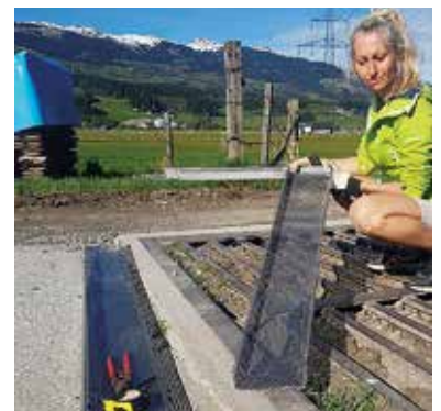
Mit dem fachgerechten Einbau von Lochblechen in Viehsperren können viele Amphibien und andere Kleintiere aus diesen „Tierfallen“ gerettet werden. Die Lochbleche dienen den Tieren dabei als Aufstiegshilfe © WILLI SCHWARZENBACHER
