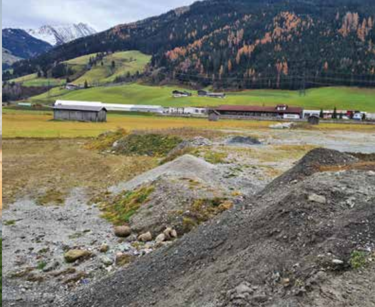
Ist diese Aufschüttung im Hochwasser-Rückhalteraum in Mittersill legal? © H. AUGUSTIN
