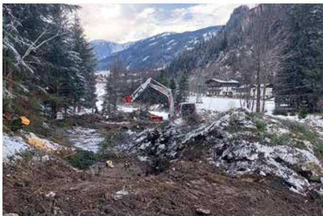
Erdarbeiten für die Teichanlage
