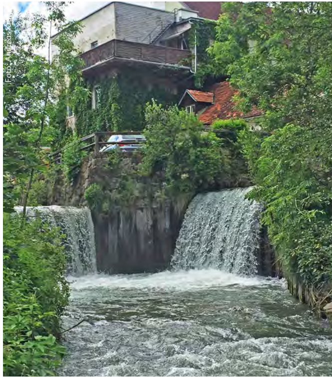
... und Querbauwerke, die dem Hochwasserschutz dienen, führen zu einer in der Regel irreversiblen Degradierung des Lebensraumes der Fische.
