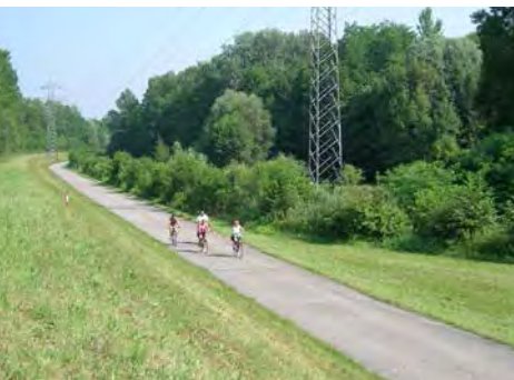
Rückstaudamm des Kraftwerkes Obervogau mit asphaltierter Begleitstraße auf gleicher Höhe wie Bild rechts; dahinter groß- flächig abgedämmter Auwald. Foto: W. Lazowski
