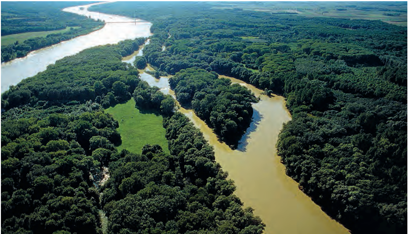
Nationalpark Donauauen. Im Rahmen des „Flussbaulichen Gesamtprojektes Donau“ wird versucht, der laufenden Sohlerosion und Flussbetteintiefung durch Zugabe von Grobkies (Granulometrische Sohlverbesserung) sowie durch ökologische und wasserbauliche Sanierungsmaßnahmen im gesamten Abflussbereich zu begegnen. Foto: R. Golebiowski & G. Navara
