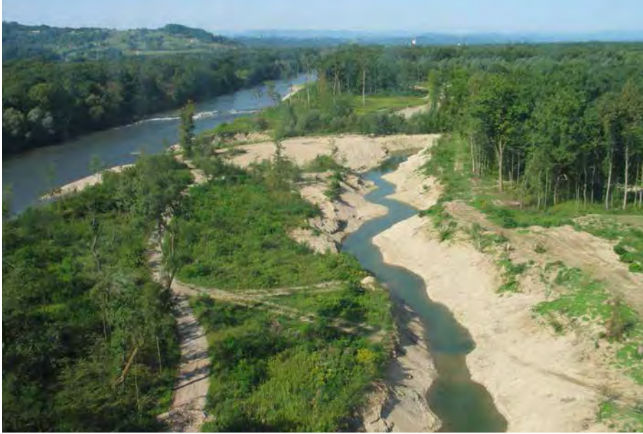
Muraufweitung Gosdorf nach den Baumaßnahmen. Foto: J. Gepp
